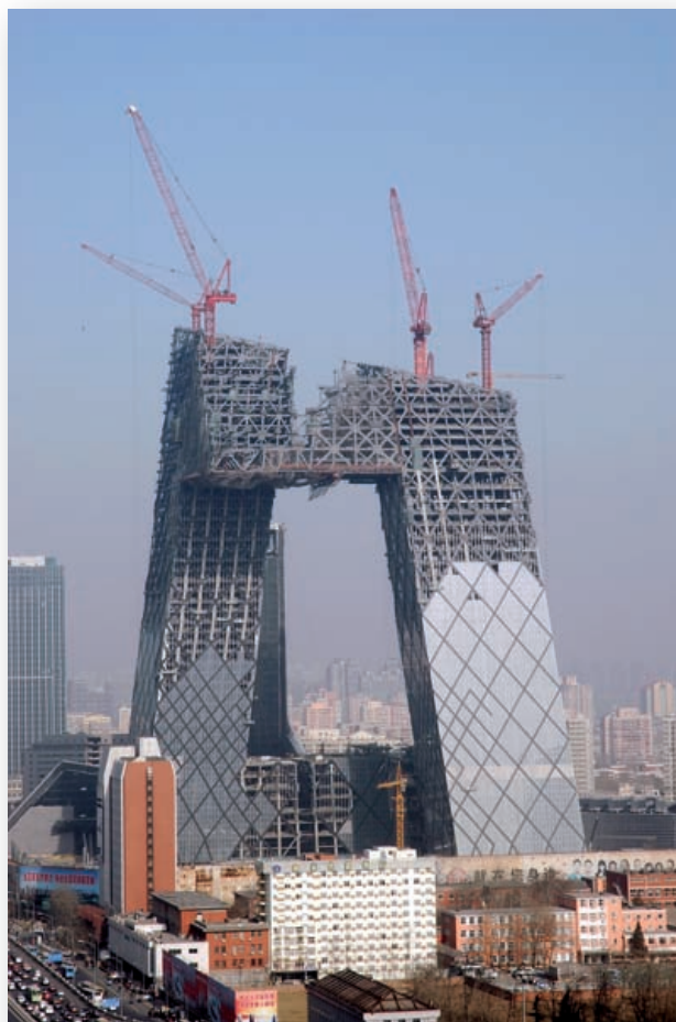
Het CCTV-gebouw, van de Nederlandse architect Rem Koolhaas, in aanbouw in januari 2008.
